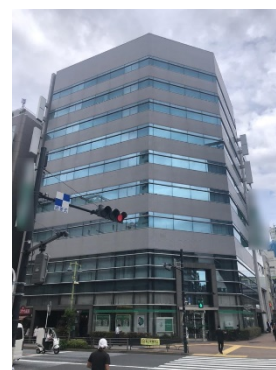
堀正工業が入居していたビル
